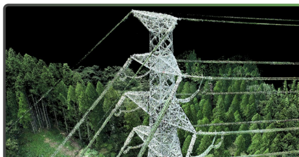
鉄塔構造物のUAVレーザー計測調査
