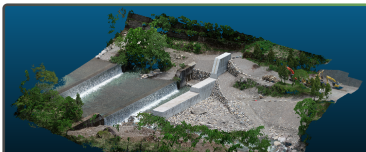
国土交通省砂防工事起工及び出来形測量
